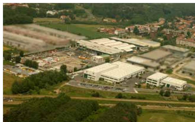
IMPIANTI DI PRODUZIONE
